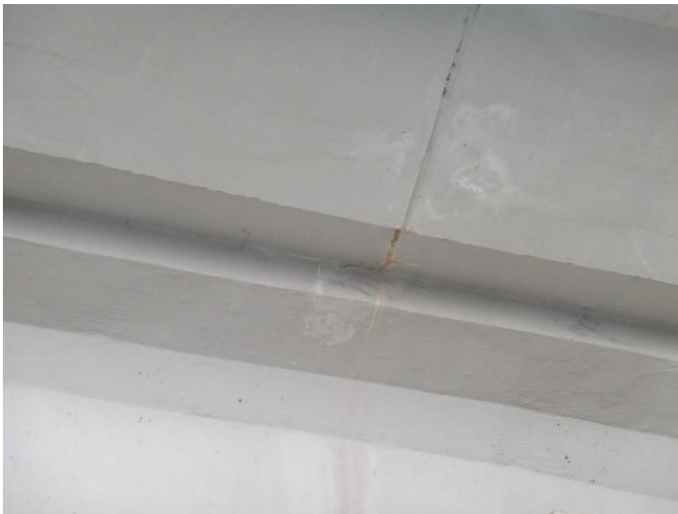
Obr.F55-17 Příklad zatékání přes příčnou spáru mezi dílci prefabrikované římsové konzoly na pravé fasádě mostu. Pohled zprava doleva (po vodě), ve směru staničení a vzhůru,
