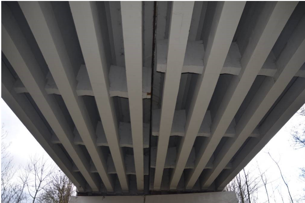
Obr.F55-09 Podhled části (přibližně první poloviny nosné konstrukce). Pohled proti směru staničení k první podpěře a vzhůru,
