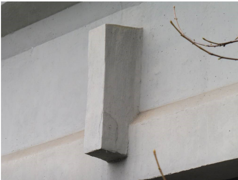
Obr.F55-15 Zárodek mezilehlého příčnicku (č.3) na levé fasádě nosníku č.1. Pohled ve směru staničení a zleva doprava (proti vodě),
