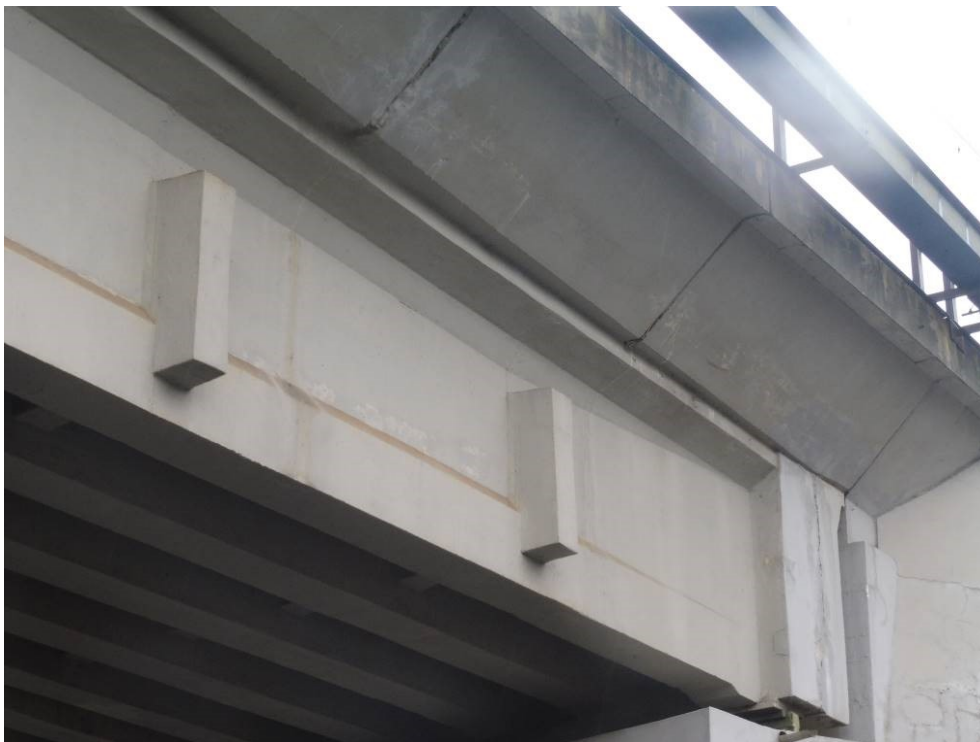
Obr.F55-13 Stopy po zatékání do kabelových kanálků předpínací výztuže na konci pravé fasády nosníku č.10. Pohled zprava doleva (po vodě) a ve směru staničení,
