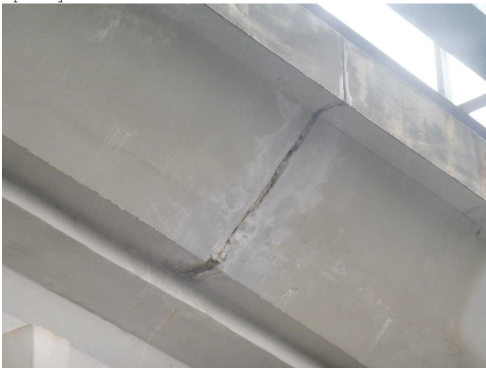
Obr.F55-18 Příklad zatékání přes příčnou spáru mezi dílci prefabrikované římsové konzoly na pravé fasádě mostu. Pohled zprava doleva (po vodě), ve směru staničení a vzhůru,
