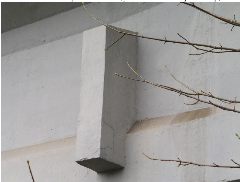
Obr.F55-14 Zárodek mezilehlého příčníku (č.2) na levé fasádě nosníku č.1. Pohled ve směru staničení a zleva doprava (proti vodě),
