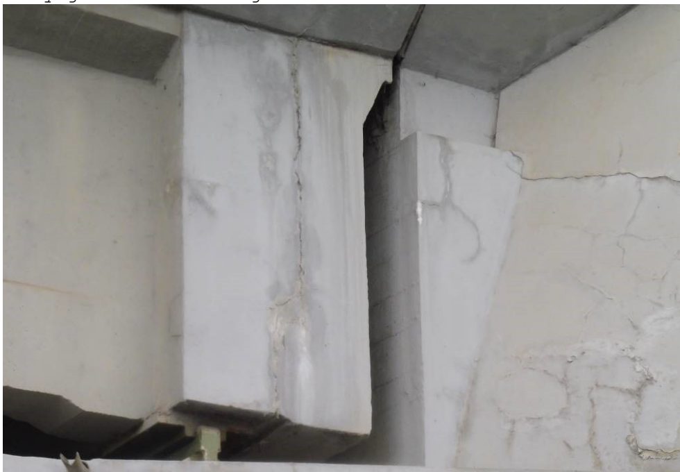
Obr.F55-12 Odtržení dobetonávky konce nosníku č.10 na 2. podpěře, pravobřežní opěře. Pohled zprava doleva (po vodě), ve směru staničení a vzhůru,
